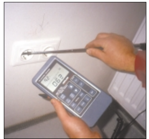
27 Steckdosenornado beim Blower-Door-Test
