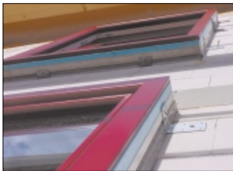
14 Fenster im eingebauten Zustand vor Anbringung des Wärmedämmverbundsystems
