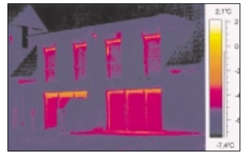
b) Gute Ausführung eines Passivhauses (Infrarot-Thermografie)
