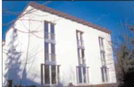
Abb 6: Südansicht eines Passivreihenhauses in Stuttgart-Feuerbach
